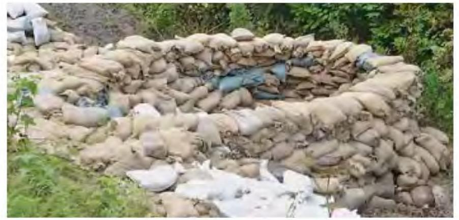
Stützung des Deiches durch Anlegen eines Auflastfilters
